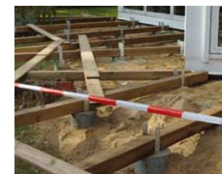
Bei nachher nicht sichtbaren Terrassen-Punktfundamenten für H-Anker haben sich die handelsüblichen „KG-Rohre“, die eingegraben und mit Magerbeton gefüllt werden, bestens bewährt.
